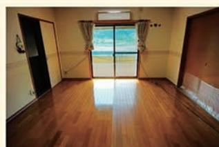
▲フローリング施工例。右半分が施工前、左半分が施工後だ。家具の移動、ワックスはがしからコーティングまで、工期はわずか1日。ピカピカなのに滑りにくいコーティングは、ペットにもやさしい。
