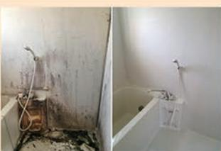
▲ユニットバスのコーティングの施工例。施工前の頑固な黒カビは研磨で落とし、コーティング。リフォームより修繕費用を抑えられる。ガラスコーティングにより、カビの根が生えにくくなり、水回りの掃除がが楽ちゃんに！
